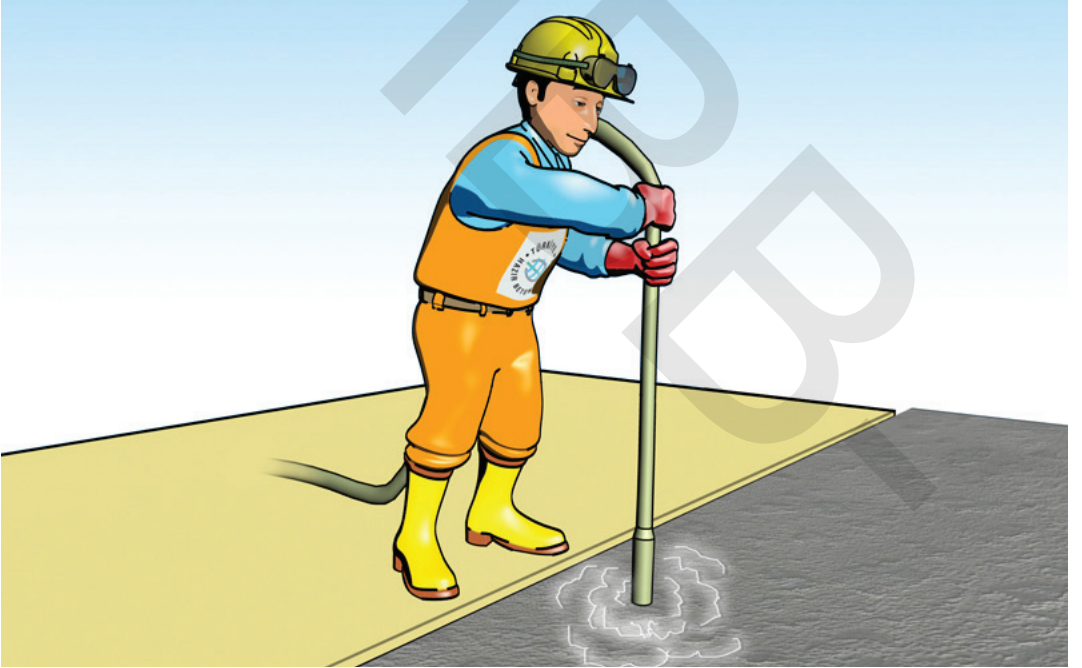
Resim 8: Vibrasyon uygulamasında kullanılan vibratör tipi beton tabaka kalınlığına göre seçilmelidir.
