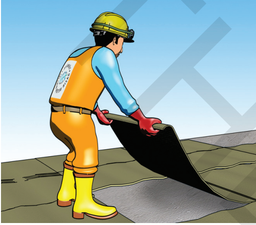
Resim 13: Beton yüzeyine telis bezi serilmesi
