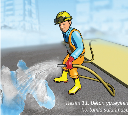
Resim 12: Beton yüzeyinde su püskürtme ile kür yapılması.
