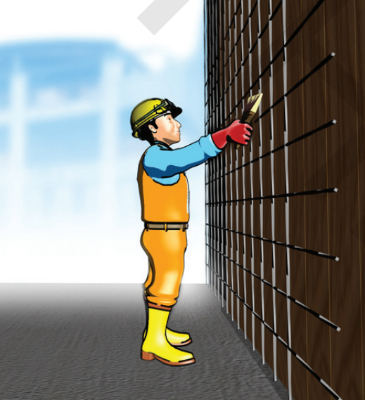
Resim 1: Kalıpların yağlanması
