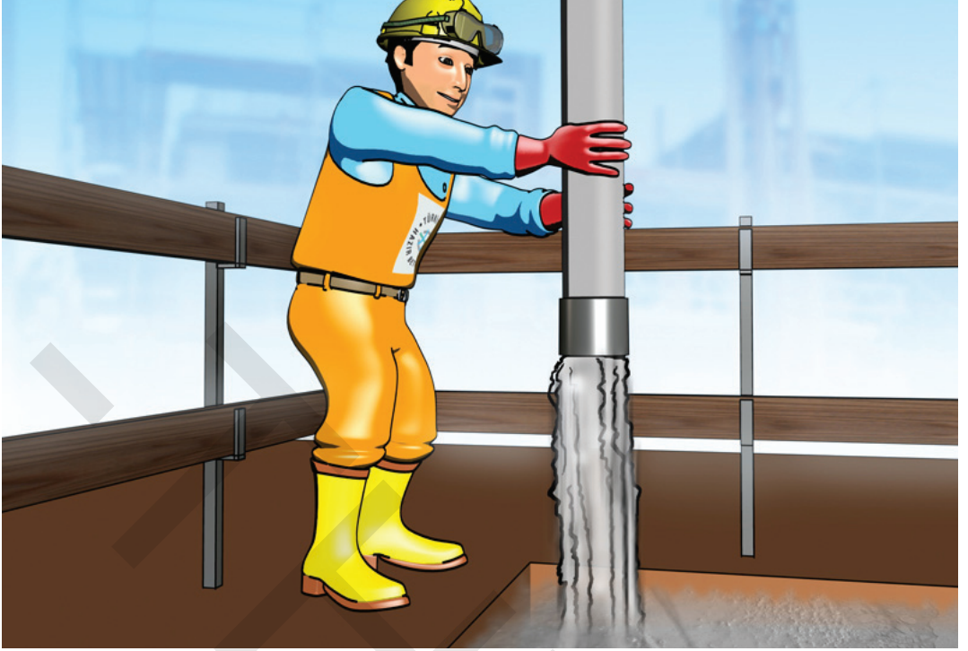
Resim 3: Beton kalıba en fazla 1.5 metre yükseklikten dökülmelidir.
